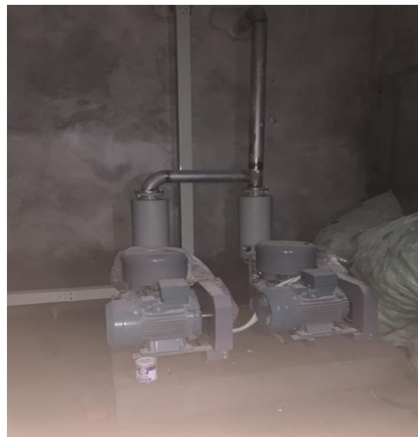
Hình 3. 9. Máy thổi khí
